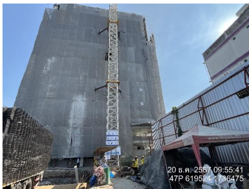
รูปที่ 33 ติดตั้งผ้าใบก่อสร้าง (Mesh Sheet) คลุมตัวอาคาร
