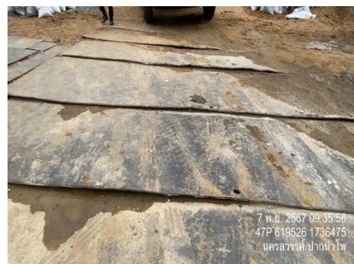
รูปที่ 23 ปูแผ่นเหล็ก
