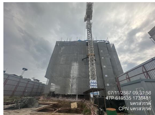
รูปที่ 33 ติดตั้งผ้าใบก่อสร้าง (Mesh Sheet) คลุมตัวอาคาร
